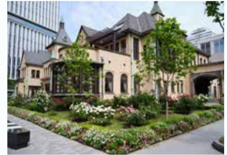
東京ガーデンテラス紀尾井町は旧ランドプリンスホテル赤坂の再開発事業。緑を多く残した形で開発が行われ、歴史ある旧李家東京邸も敷地内で移設・改修。現在は「赤坂プリンス クラシックハウス」として運営しています（画像提供：株式会社西武プロパティーズ）
